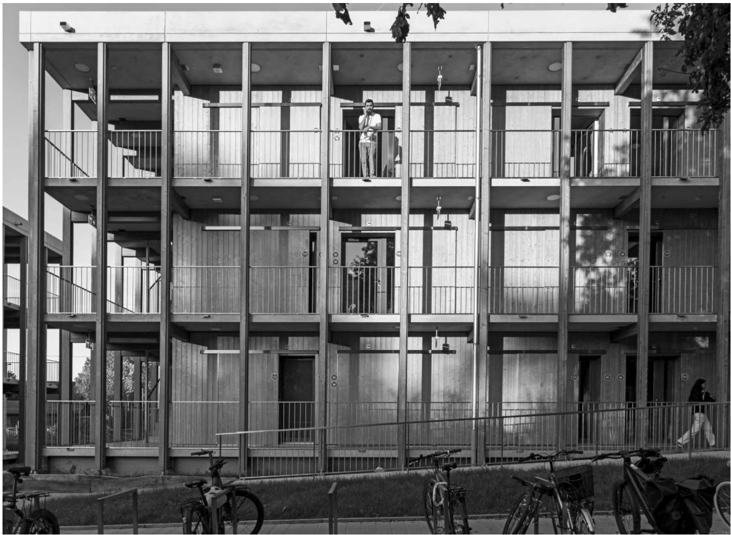
L'achèvement des travaux aux Cherpines concrétise la mise à disposition de nouveaux logements davantage pensés à taille humaine, avec des appartements pour les familles et des formes de colocation pour les personnes seules. ©JEAN-MICHEL ETCHEMAÏTÉ/REGARDIRECT.CH
